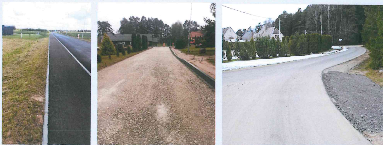
Tirkšlių mstl. Saulės g. kapitalinis remontas (kairėje), Užlieknės k. Liepų g. dalinis remontas (viduryje) ir Krakių k. Liepų g. kapitalinis remontas (dešinėje)
