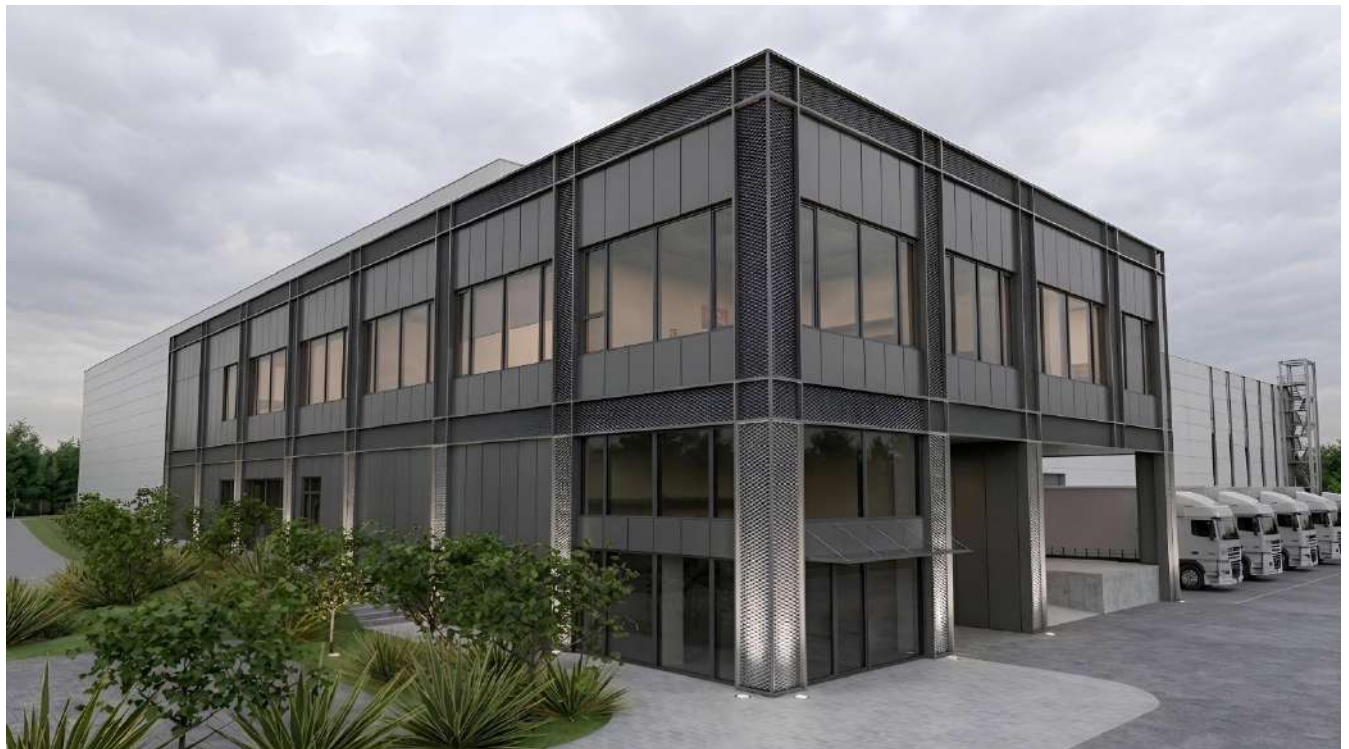
6 pav. 01 pastato vaizdas iš rytų pusės
